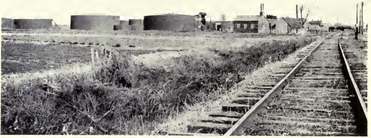
FIG. 95.—LOUISIANA. STORAGE TANKS.
